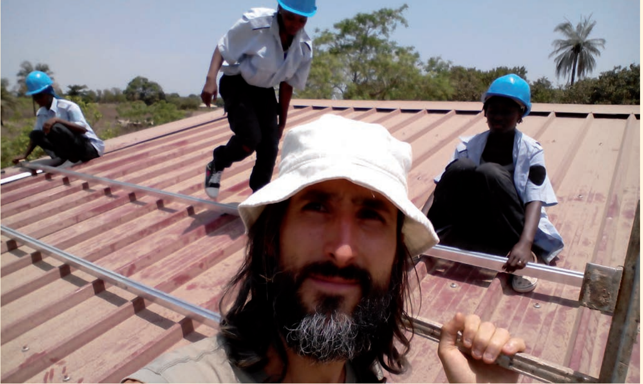
En Joan a Gàmbia. "Era un projecte sobre energia solar per un poblat que no té llum. Les plaques les van instal·lar dones a través d'un programa de formació d'instal·lació i manteniment de plaques solars".
